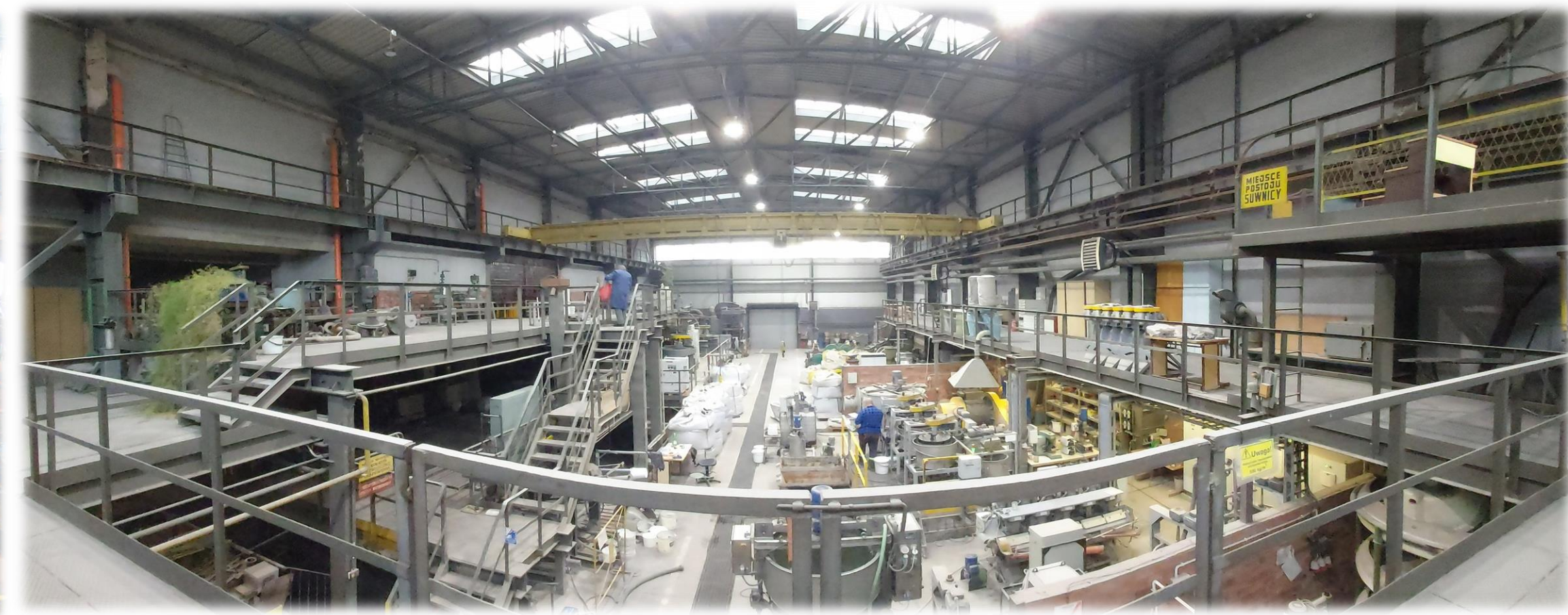
Hala technologiczna Centrum wraz z wyposażeniem do badań w skali pilotowej.
